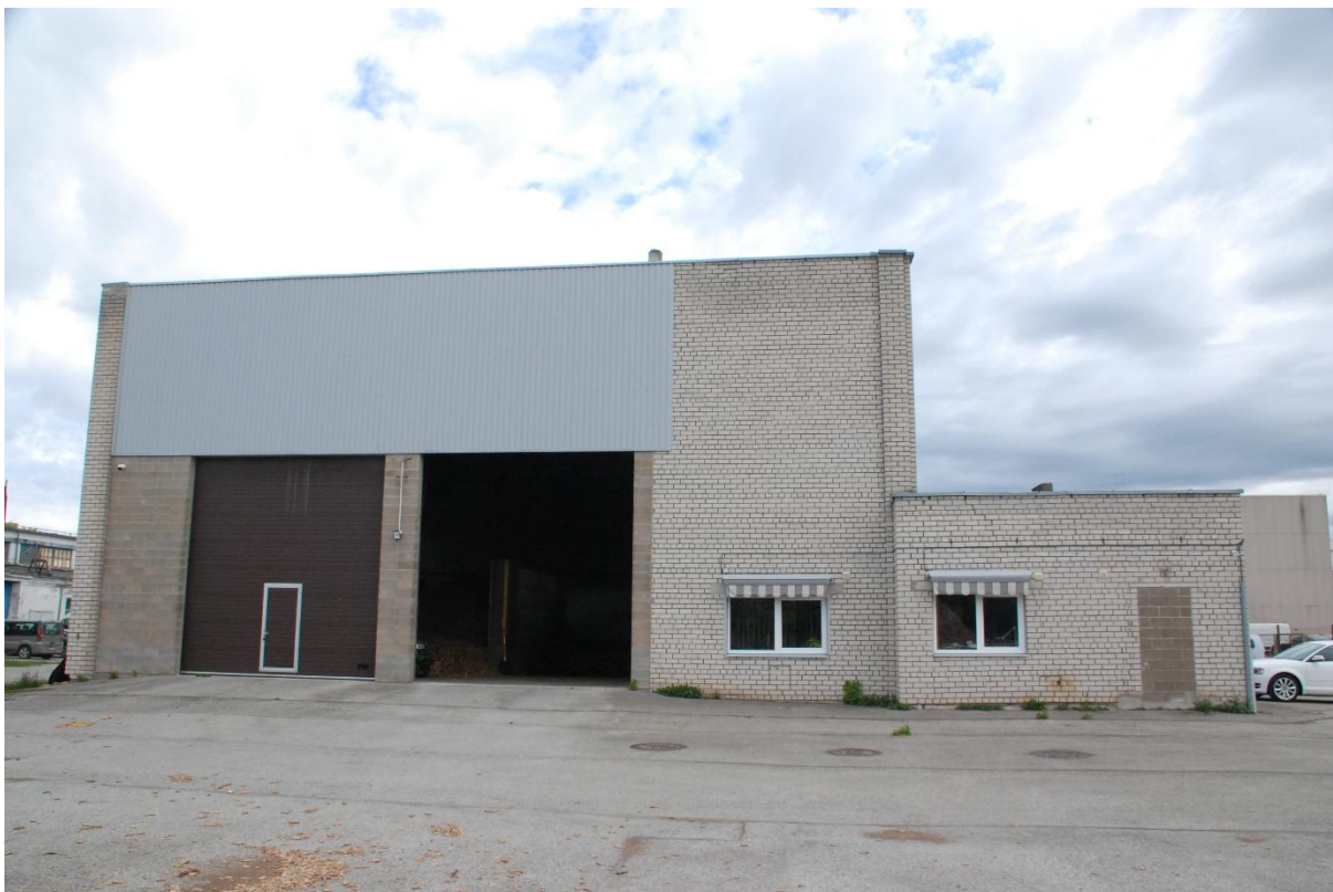
Kuusalu katlamaja hakkelaosissepääs
