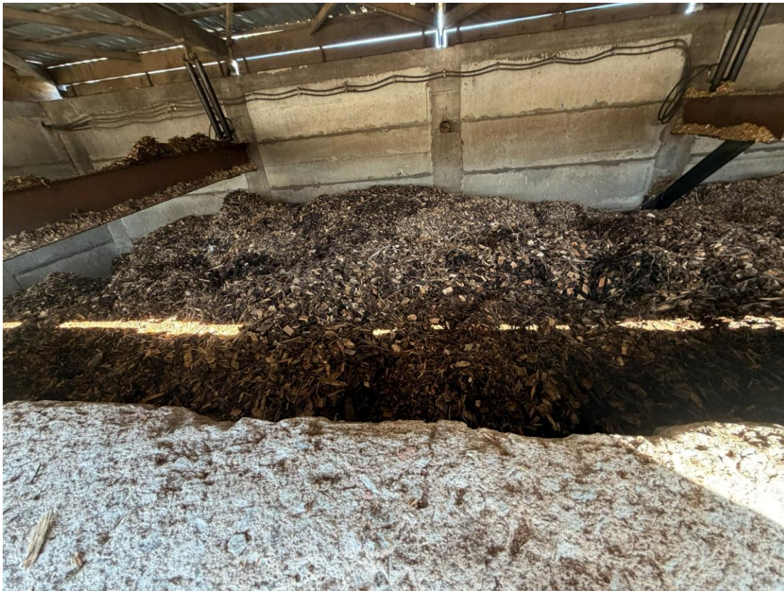
Kolga vastuvõtu punker
